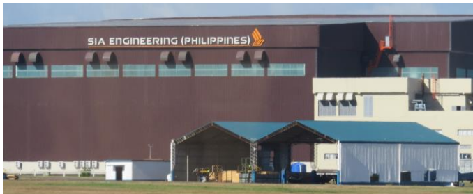
シンガポール航空子会社が出資する 航空機整備事業会社の格納庫
