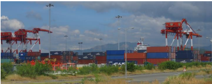
JICAの支援で整備されたコンテナ荷役設備
