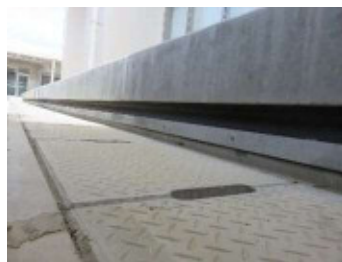
(センター床下の様子)
