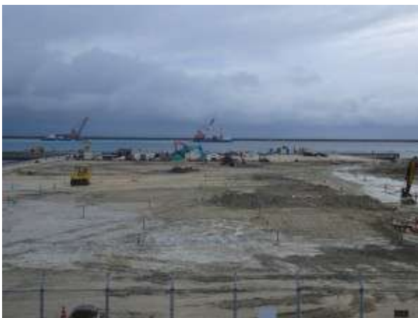
▲建設中の第二クルーズバース視察時
