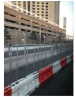
<市内道路は工事中>
