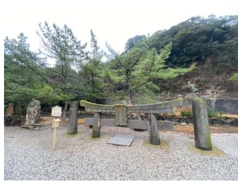
(台風の厄災を引受けて倒壊した身代わり鳥居)
